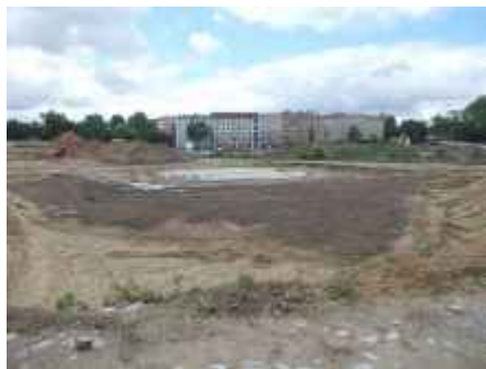
Bauphase im Juni 2012
